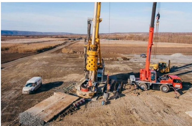
Budowa mostu granicznego przez Dniestr na ukraińsko-mołdawskiej granicy w pobliżu miejscowości Jampil - Koseuts
