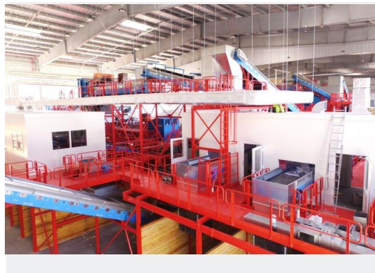
Inżynier kontraktu oraz nadzór inwestorski - Instalacja recyklingu organicznego poprzez fermentację bioodpadów
