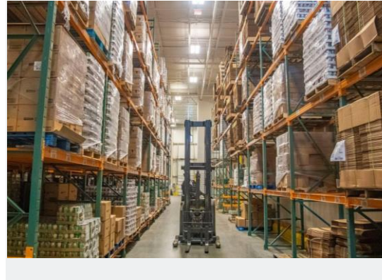
Inżynier Kontraktu - Budowie hali produkcyjno-magazynowej wraz z infrastrukturą techniczną i zapleczem socjalno-biurowym
