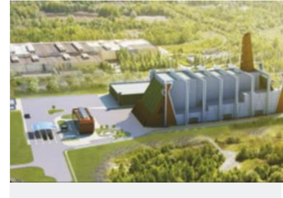
Inżynier Kontraktu - Budowa Instalacji Odzysku Energii wraz z niezbędną infrastrukturą techniczną i towarzyszącą
