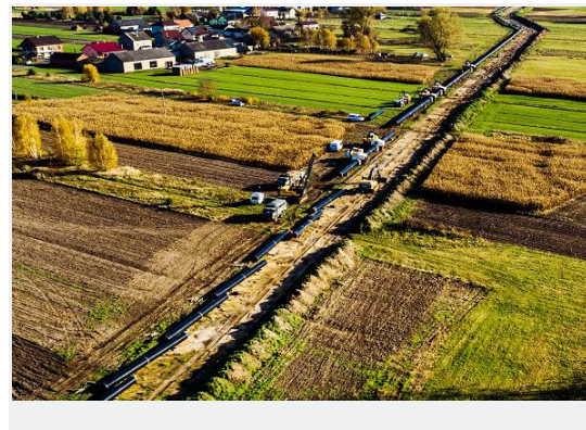
Inżynier Kontraktu - Budowa gazociągu wysokiego ciśnienia DN500 MOP 8.4 MPa -odgałężenie do bloku gazowo-parowego w Rybniku wraz z budową Stacji Pomiarowej Rybnik
