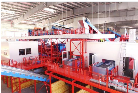
Inżynier kontraktu oraz nadzór inwestorski - Instalacja recyklingu organicznego poprzez fermentację bioodpadów
