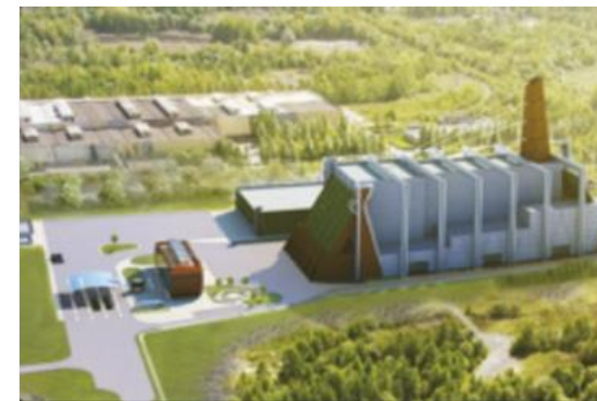
Inżynier Kontraktu - Budowa Instalacji Odzysku Energii wraz z niezbędną infrastrukturą techniczną i towarzyszącą
