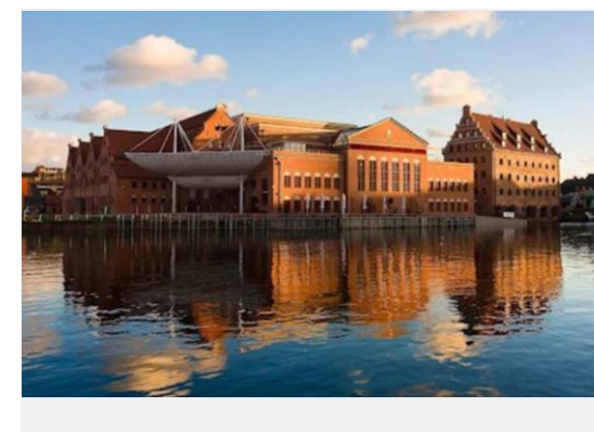
Wielobranżowe doradztwo - Przebudowa oraz rozbudowa budynku dawnej Nastawni na Salę koncertową z zapleczem administracyjno-technicznym dla Polskiej Filharmonii Bałtyckiej w Gdańsku wraz ze Strefą Kultury
